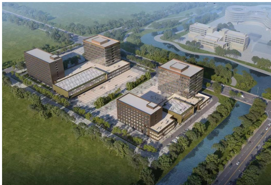
麟龙四期园区（建设中）
